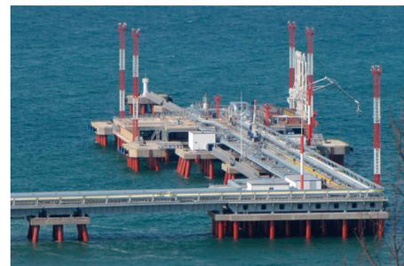
в грунт на глубину до 60 метров. В проекте использовались как вертикальные, так и наклонные сваи. Это позволило уменьшить их количество до 234 штук;
