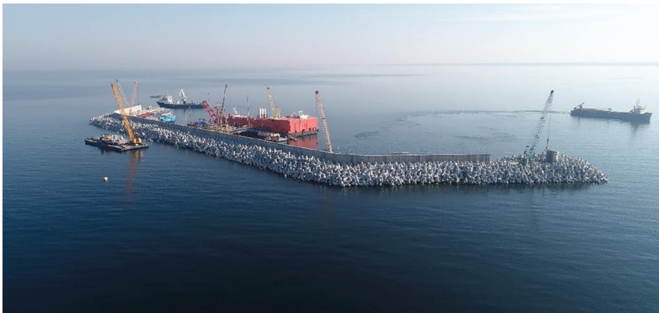
СТРОИТЕЛЬСТВО ВОЛНОЗАЩИТНОГО СООРУЖЕНИЯ КАЛИНИНГРАДСКОГО ТЕРМИНАЛА СПГ
